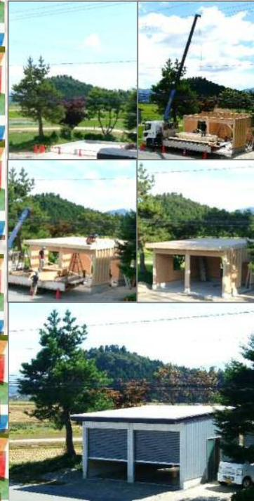
夏に始まった、車庫の新築工事。無事完成致しました。画像では、わかりにくいのですが、屋根と外壁の色は、シルバー。外壁材は、ガルバリウム鋼板の素地材を使用しております。
