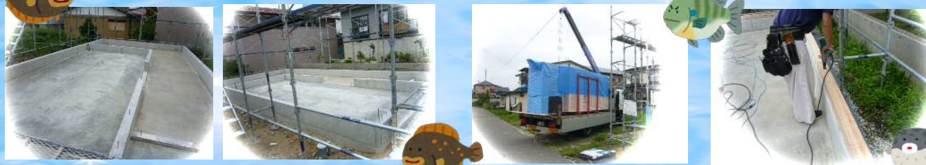
新庄市 K様邸 いよいよ建方が始まります。 写真は土台敷きの様子。二日後には上棟します。また来月報告しますね
