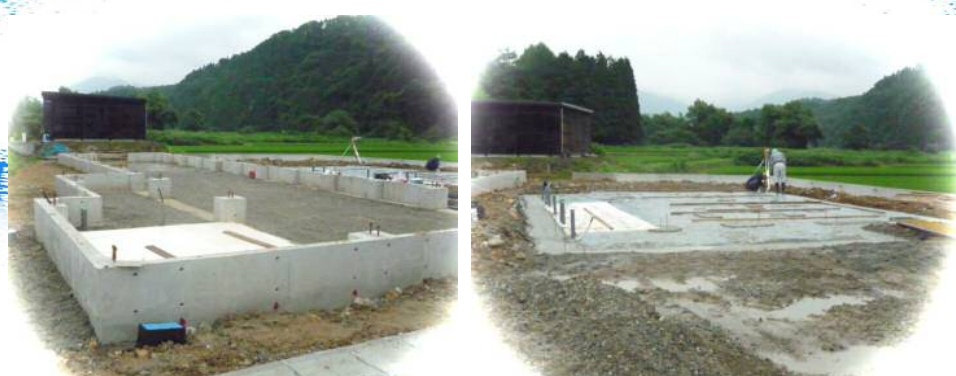
最上町 U様邸 基礎工事の様子。 お盆あけに上棟予定です！
